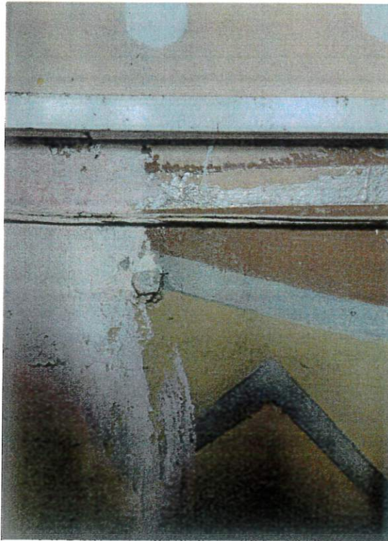
Pawłowice, kościół pw. św. Jana Chrzciciela, ślady zachowanej polichromii z pocz. XX w. (ściana prezbiterium)
