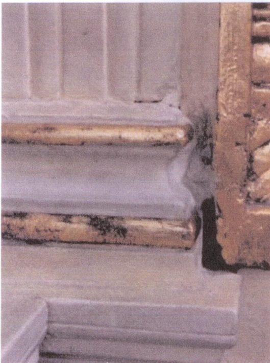
Zniszczenia struktury architektonicznej dekoracji malarskiej i pozłotniczej.
