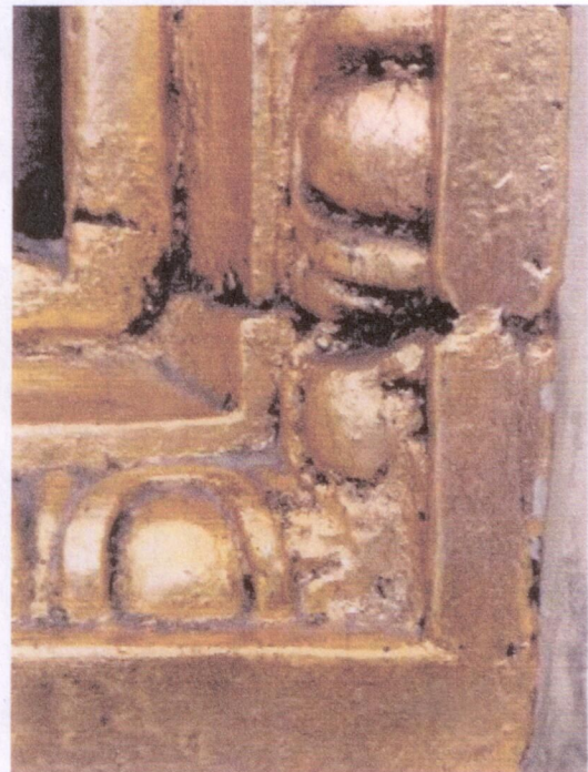
Zniszczenia struktury architektonicznej dekoracji malarskiej i pozłotniczej.
